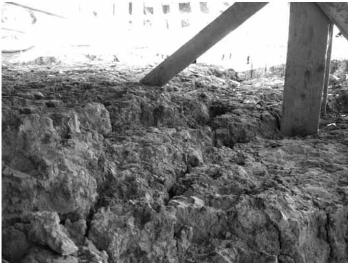
Εικ. 5 Οι επιφανειακές ρωγμές του σεισμού, όπως αυτές διατηρήθηκαν λόγω του υλικού που κάλυψε το γεωλογικό υπόβαθρο.
